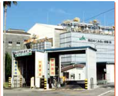
トラックスケールと副原料タンク
