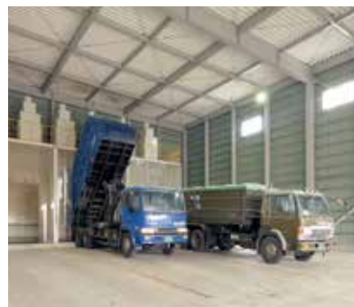
原料搬入設備
