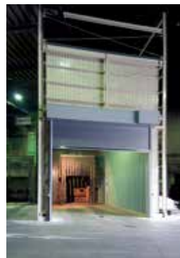
動蛋原料搬入設備
