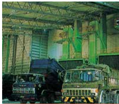
原料搬入設備
